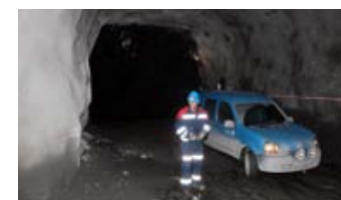
Här sprängs den nya pumpstationen.
