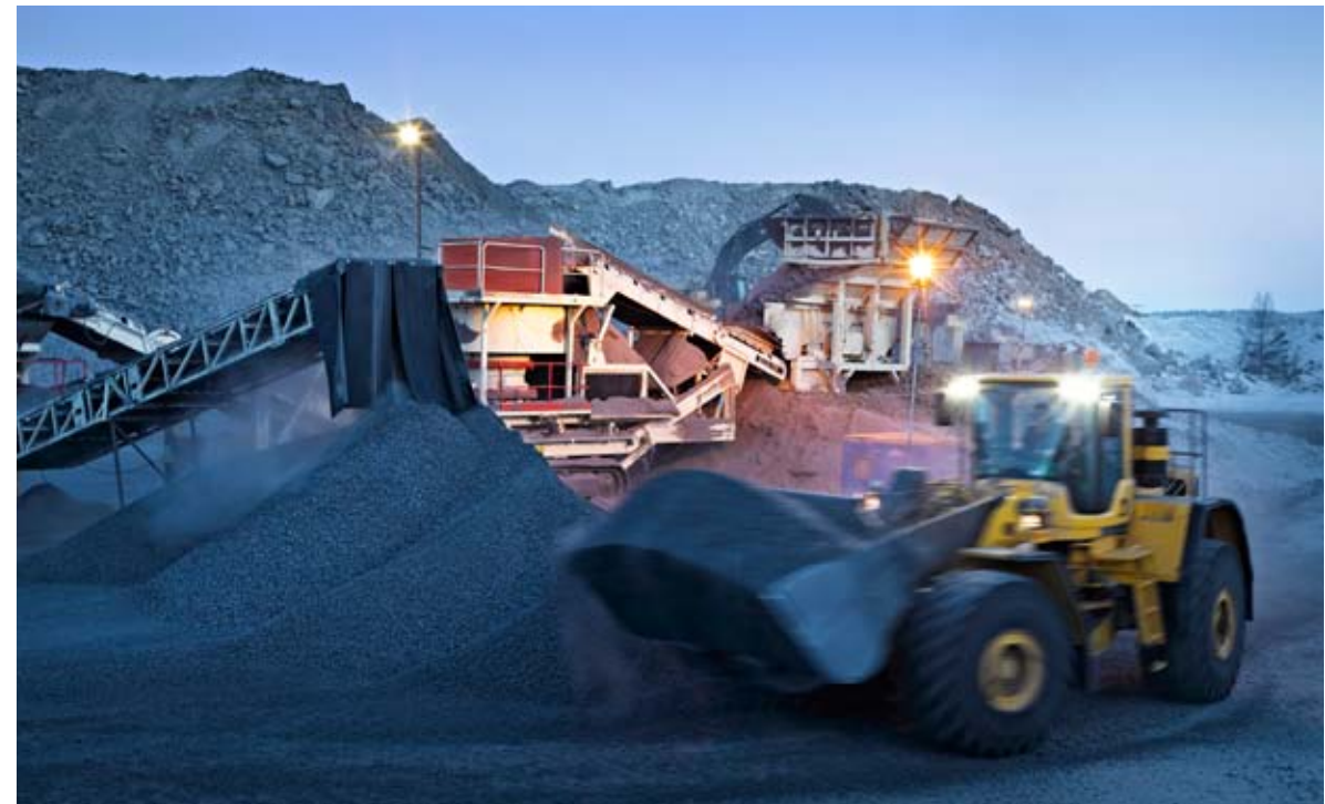
Den mobila krossanläggningen vid Gruvberget går för högtryck. Nu har den fått en ny, skyddad placering för att minska dammspridningen. Samtidigt planeras för en permanent krossanläggning som får inbyggt miljöskydd med utsug.
