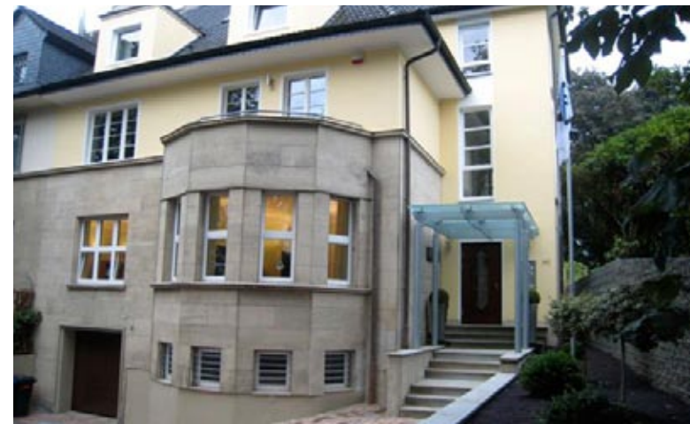
Nya fönster och extra isolering hjälper till att hålla energiförbrukningen nere.
